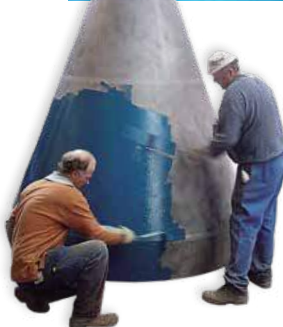
Beschichtung eines Maschinenteils WEICON Keramik BL
